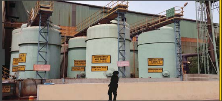
Fresh Acid: 50 KL x 1 no. FRVE Pickled Acid: 100 KL x 3 Nos. FRVS Regenerated Acid: 100 KL x 3 Nos. FRVS
